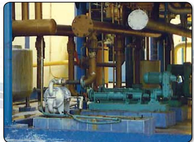
Solución que proporciona la instalación de una bomba AODD seleccionada para reducir los costos totales de propiedad y minimizar la asignación de espacio de piso.
