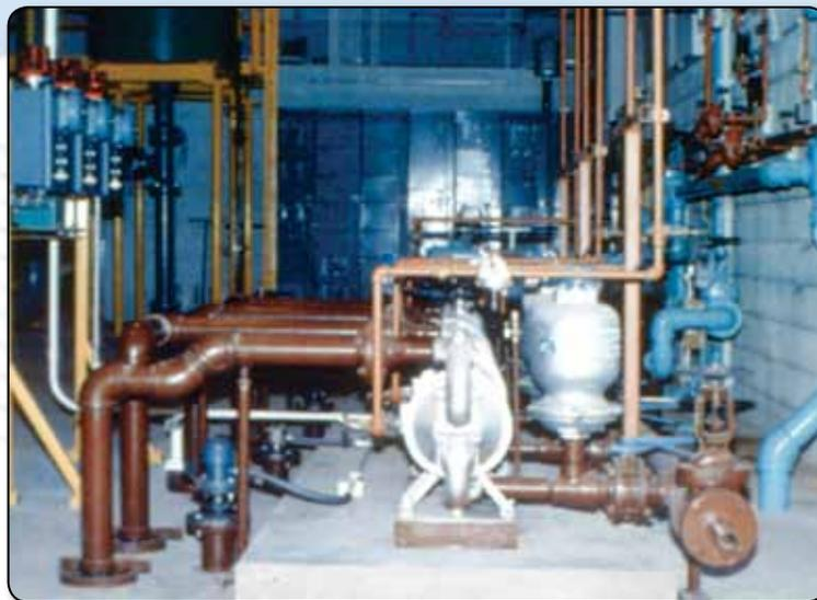
Bombas de válvula de solapa de uso intensivo con tranquilizadores permanentemente instalados en una instalación de tratamiento de desechos industriales automotrices.
